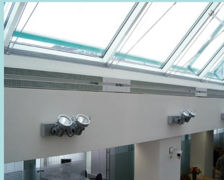
LUVAS Heiz- und Kühlelemente an der Fassade
