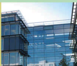
Bürogebäude Einsteinring München: Sonnenschutzelemente auf Kragarmkonstruktion
