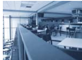
Stadion Köln [Heizkonvektoren]
